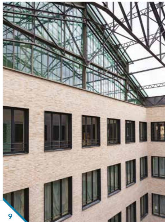
SNEF / AXIS / Marseille : Tous les lots techniques de la construction du nouvel espace de co-working et co-living Babel Community
