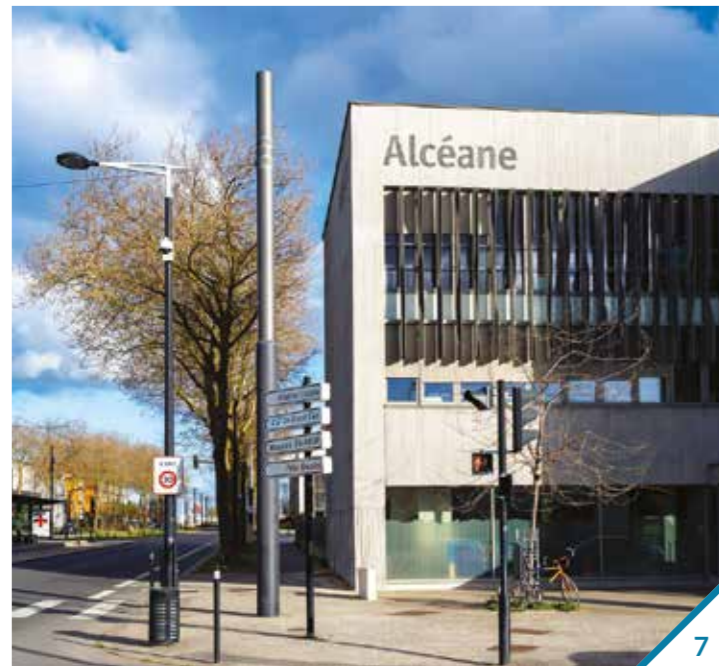
SNEF / ALCEANE / Le Havre : Vidéo-protection des bâtiments
